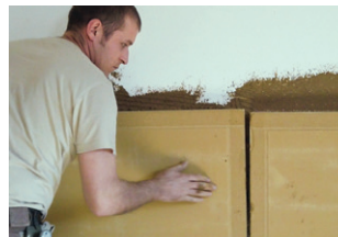
die Platte aufsetzen
