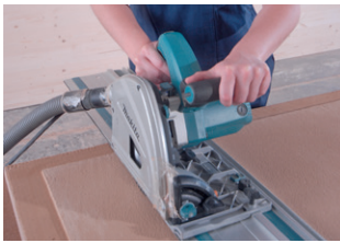
Zuschneiden der Platten
