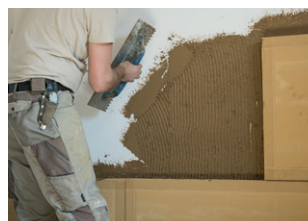
Haftfix auf Wand auftragen
