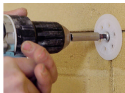
Dübel werden in die T-Fugen gesetzt
