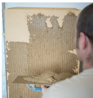
Haftfix auf Platte auftragen
